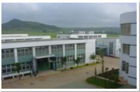
工程训练中心厂房一角
